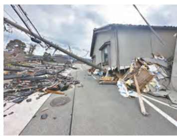
能登半島地震の被災地の状況
